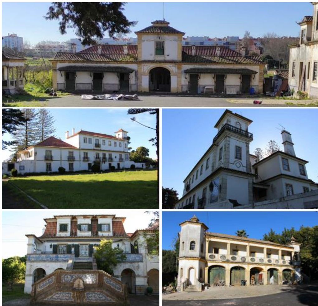
Figura 14 – Perspetiva exterior de algum do edificado histórico da Quinta do Barão (NRV, 2021a)
