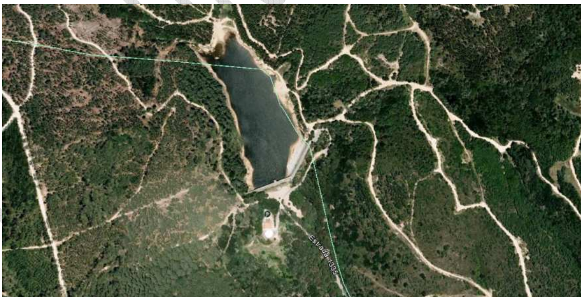
Figura 5 - Localização da Barragem do Rio da Mula e da albufeira face à Estrada da Serra e ao limite do concelho (traço a verde)
